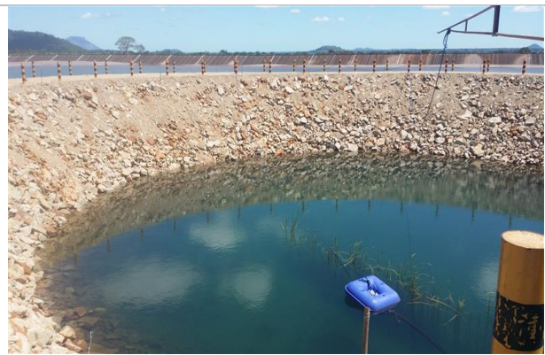
Figura v. Sistema de Filtragem existente na barragem de rejeito
